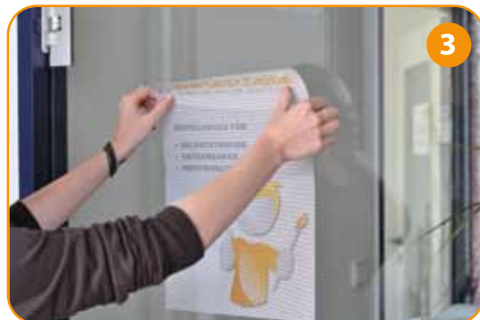
3 Lochrasterfolie an die Scheibe heften und fest andrücken (z.B. mit einer Rolle oder einem trockenen Tuch)
